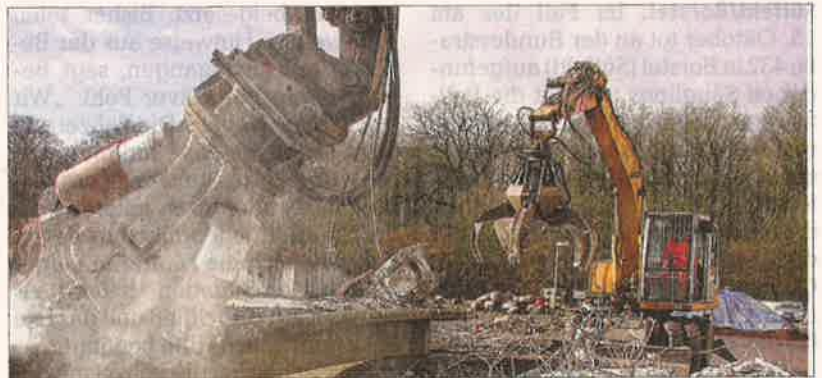
Mit Bauschutt haben die Entsorgungsbetriebe Erfahrung: Hier wird auf Niemark die abgerissene Vorwerker Brücke „zerknabbert“. Foto: Kröger
