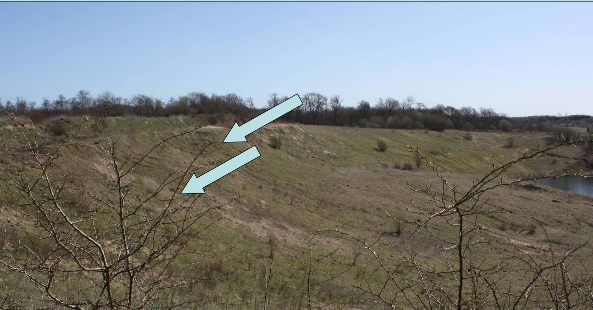
**Durch die Sand- und Schlufflinsen sickert fortwährend Wasser und drückt gegen die Böschungen; es kommt zu Rutschungen !**
